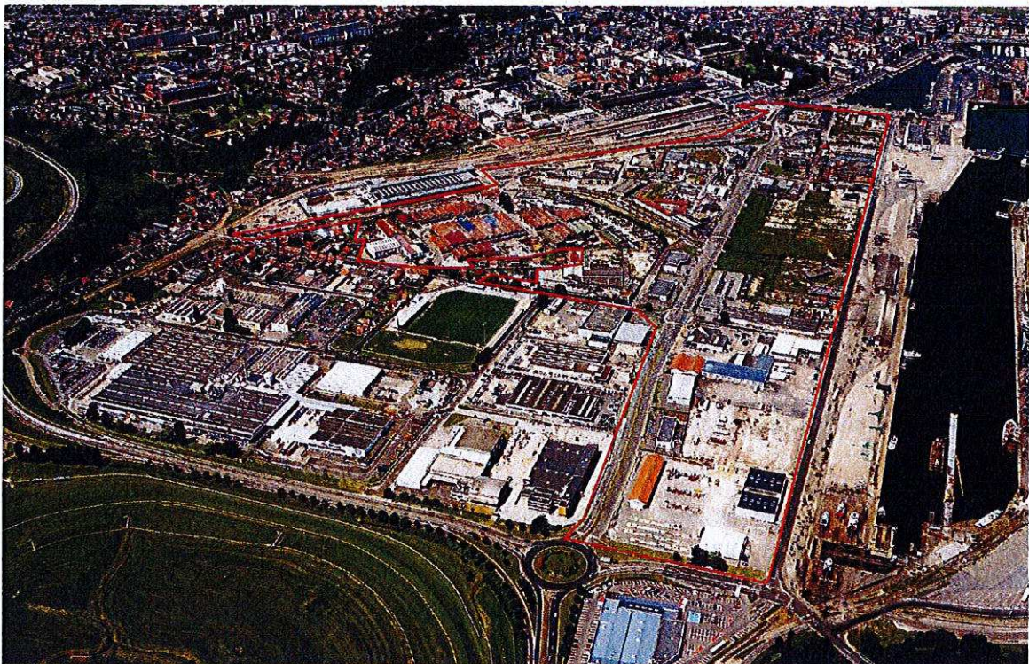
Périmètre ZAC Dieppe Sud et de la DUP – Source Ville de Dieppe/SEMAD
